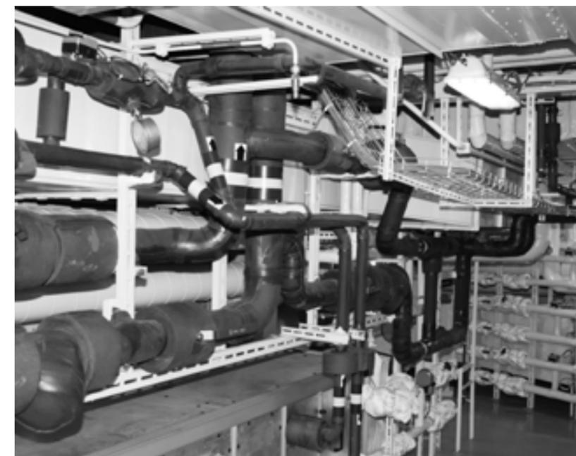
Impianto HVAC - Interno AC station: tubazioni acqua refrigerata e calda
