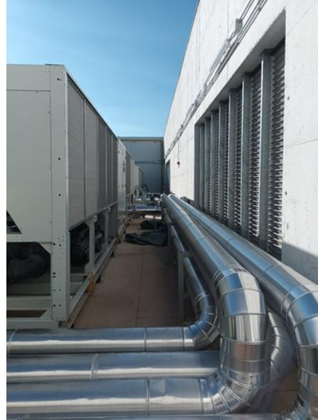
36. 37. Pompe di calore per la produzione di acqua calda all'interno del Polo Tecnologico
