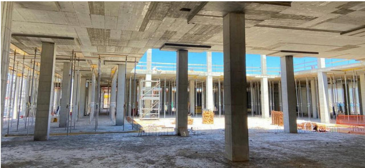
23. 24. Strutture verticali: maglia modulare e pilastri in cemento armato
