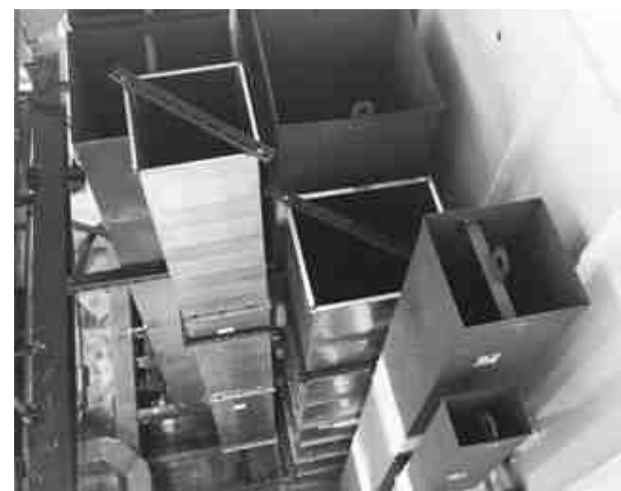
Impianto HVAC – Trunk in allestimento
