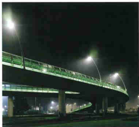
42 Viabilità di accosto: le rampe di accesso con il parapetto vetrato Vehicular access: the ramps with the glazed parapet
