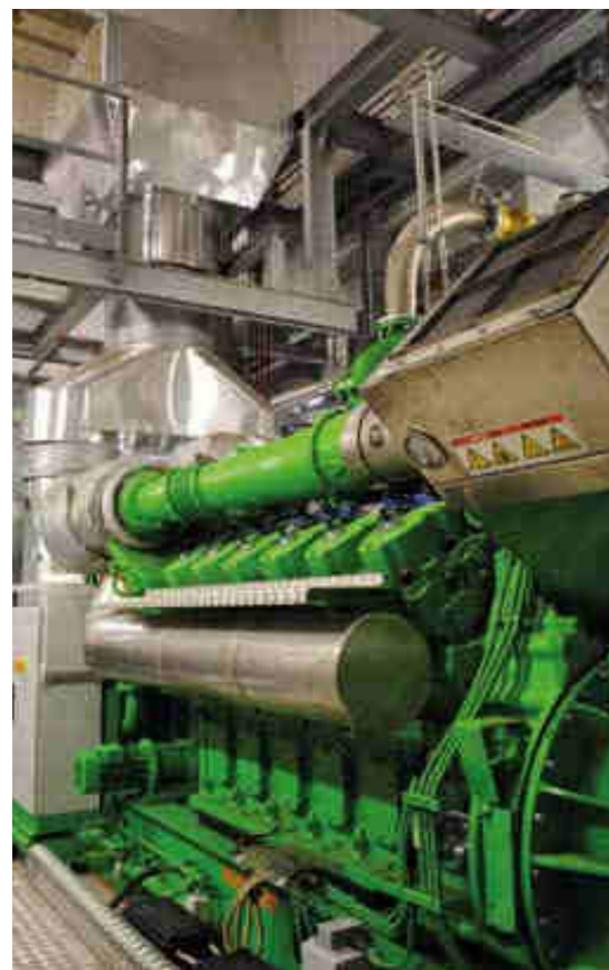
Cogeneratore da 1800 kW elettrici e 1900 kW termici.
