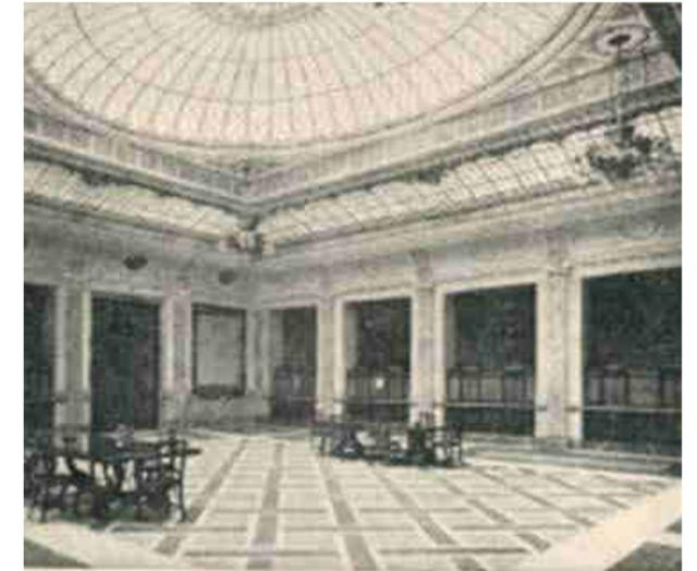
*Il salone per il pubblico nella sede della Società Edison: l'aria calda per il riscaldamento viene introdotta attraverso bocchette disposte attorno al velario, mentre la ripresa avviene attraverso griglie a pavimento.*
