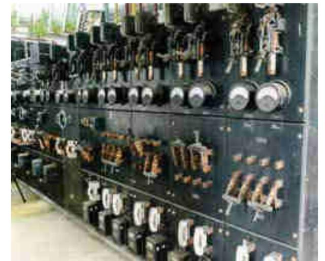
La sicurezza nei vecchi quadri elettrici: sopra, un pannello di fusibili, per una grossolana protezione dei circuiti; sotto, un quadro con interruttori a coltello, con i conduttori in tensione a vista.
