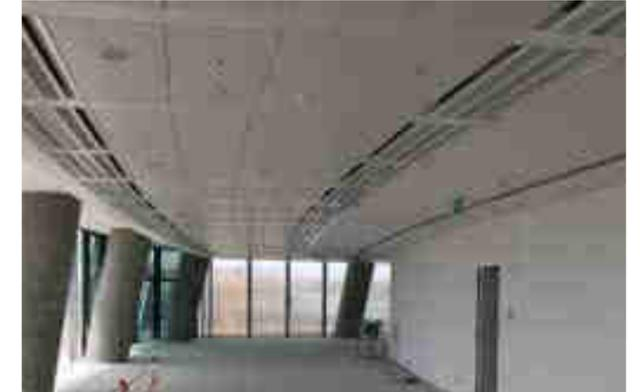
*Soffitto degli uffici completato con travi fredde, apparecchi illuminanti e sensori vari.*
