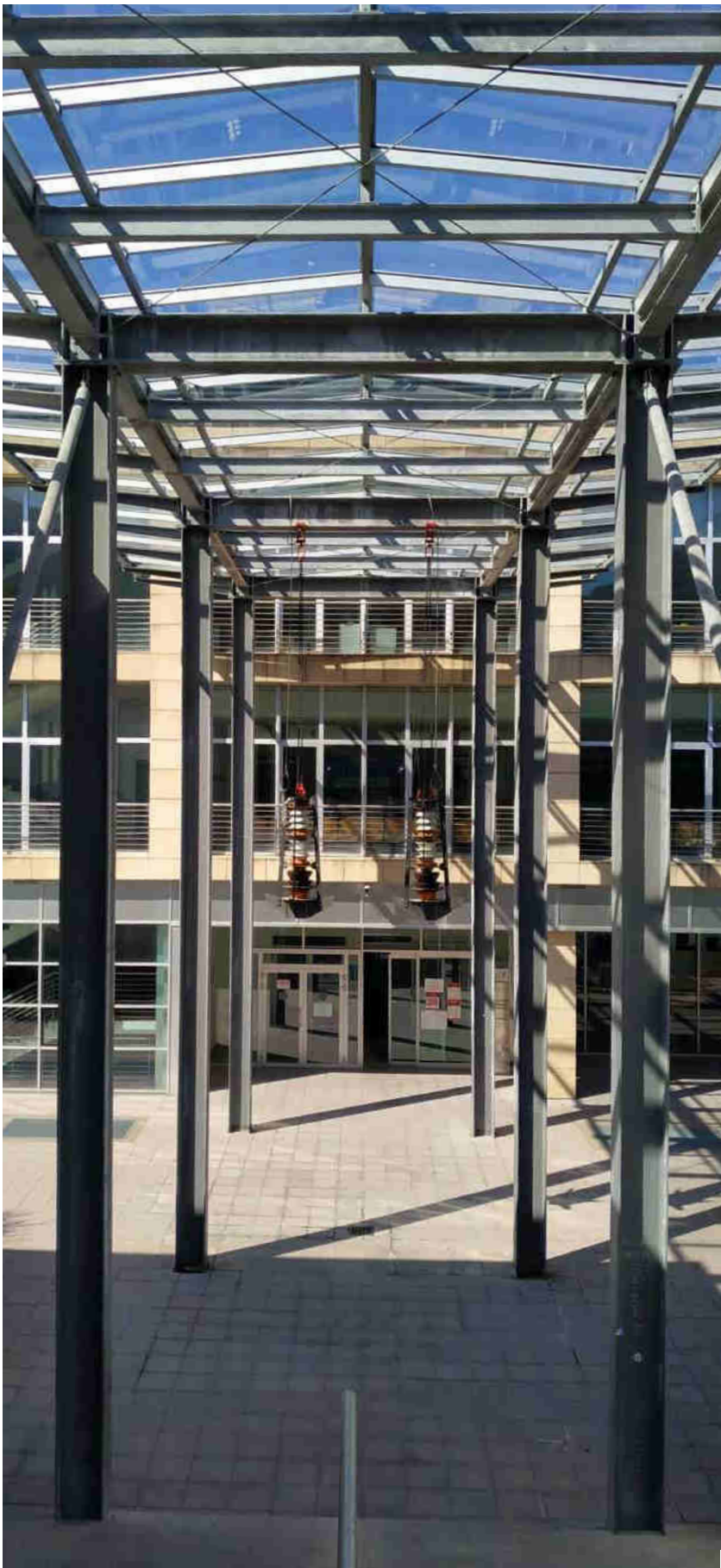
Uno degli ingressi al Blocco 1. Al centro, l'opera d'arte realizzata da A. Tadiello, omaggio all'acceleratore ionico costruito dal professor Igino Scotoni nel 1985 e dismesso nel 2004
