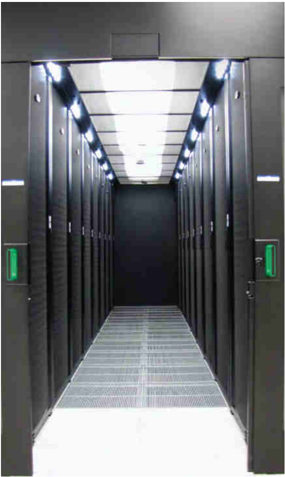
Vista del “corridoio freddo” all'interno del Data Center
