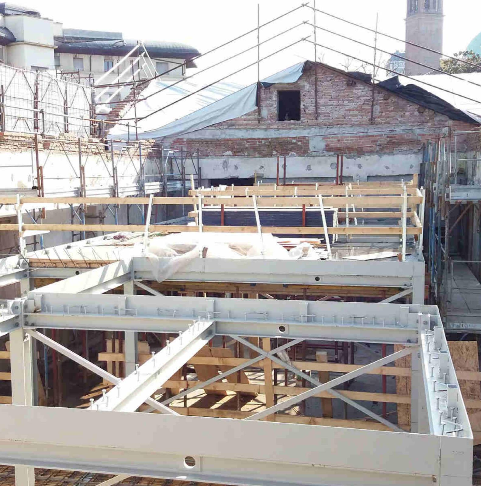
14 -15. Fasi di cantiere: montaggio struttura metallica di sostegno dei solai della biblioteca
