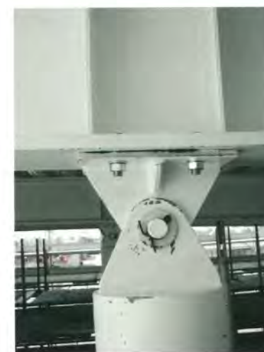
Cerniere di fissaggio a terra delle travi
