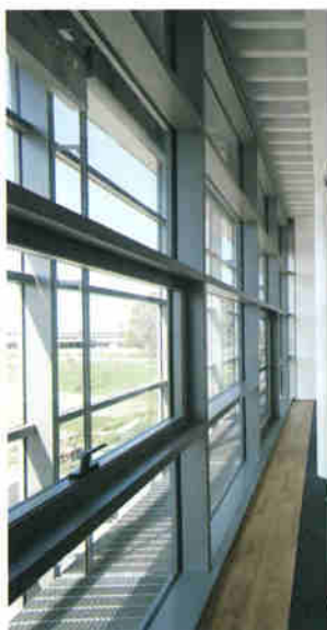
La facciata sud a doppia pelle: l'intercapedine, le lamelle motorizzate orientabili, il serramento interno, le passerelle grigliate di ispezione
