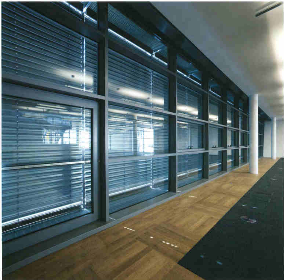
Facciata sud, dettagli costruttivi della doppia pelle
