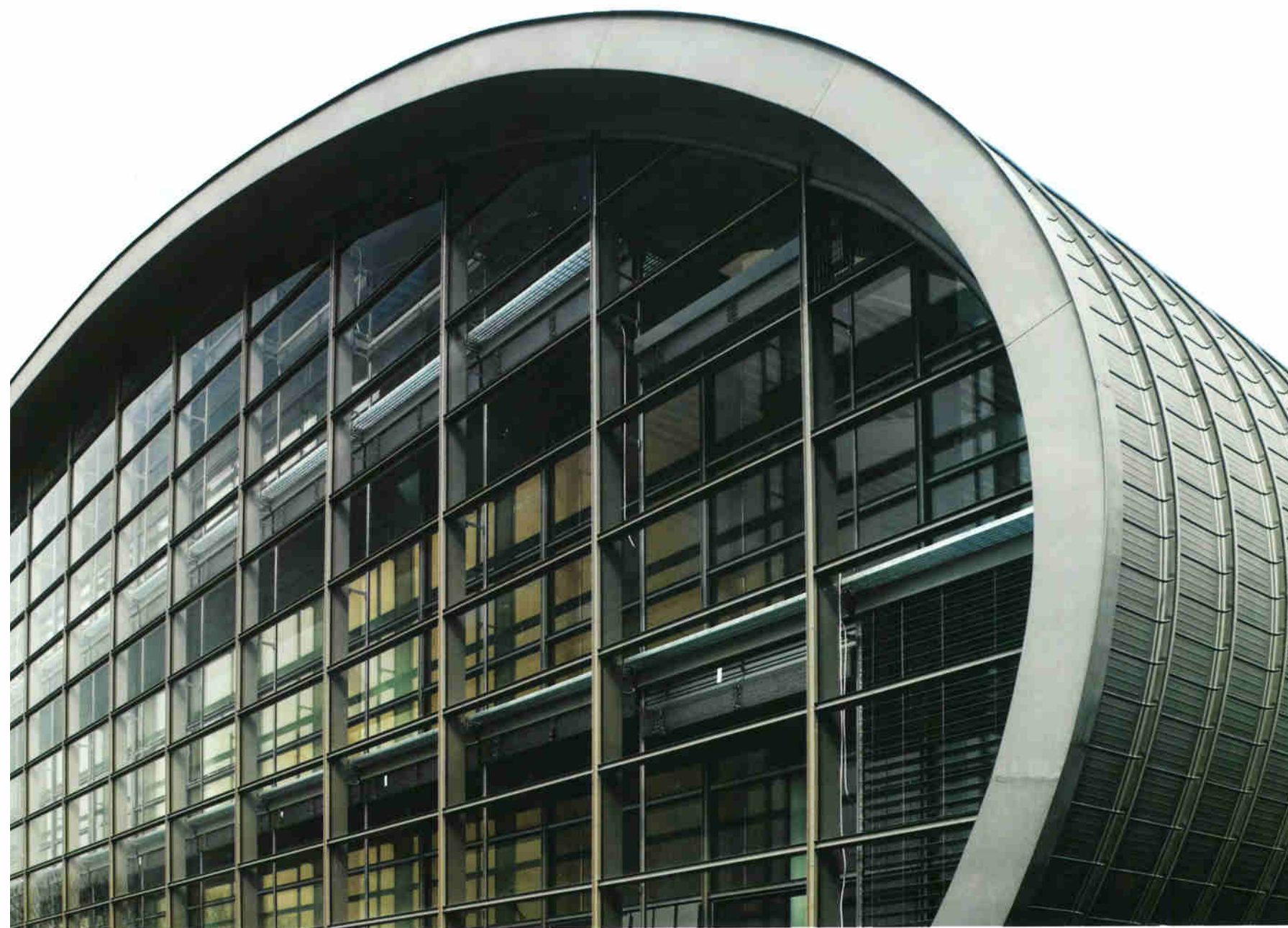
Particolare della copertura in zinco-titanio
